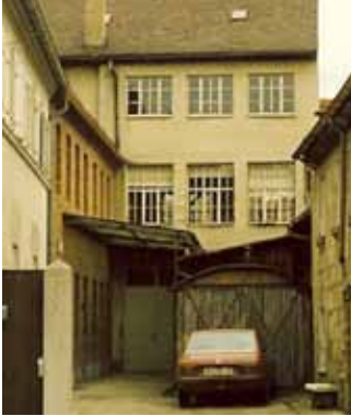
Hier, in der Kugelbühlstraße 32, begann alles (Rotes Gebäude links hinten und Rückgebäude).
