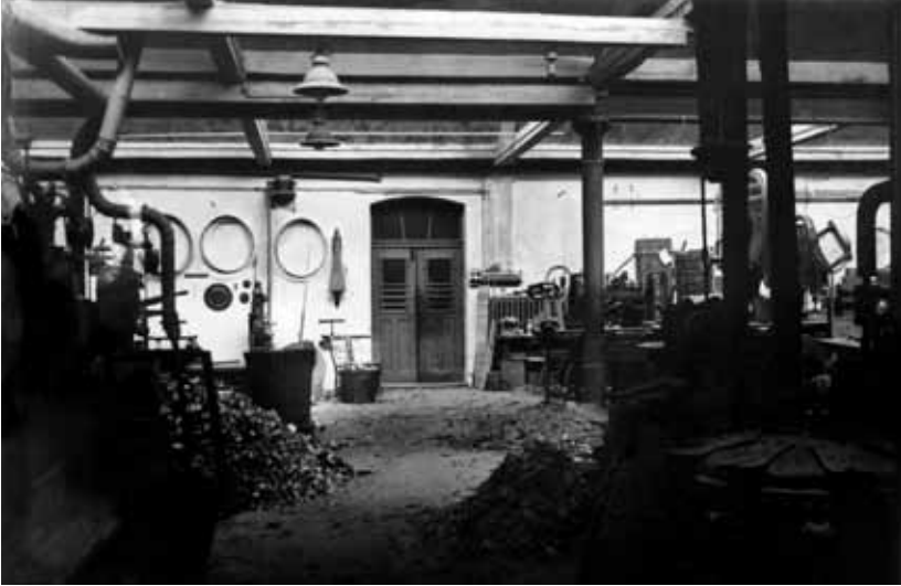
Blick in die Sheddach-Halle um 1930 (links die Blockmaschinen).
