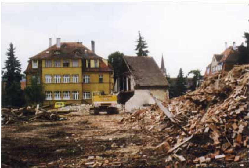
Abriss der Firma Heid in der Gartenstraße im Jahr 1988 (im Hintergrund das Wohnhaus).
