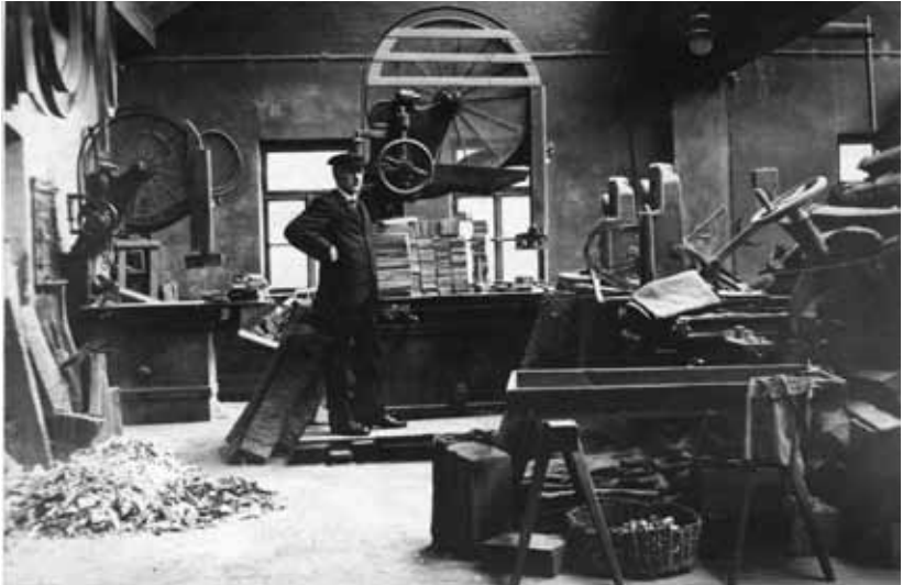
Hans Heid vor Bandsägen in der Werkshalle (Shedbau).
